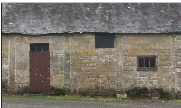
À Kermérien, des colonnes soutiennent encore la toiture des hangars.
